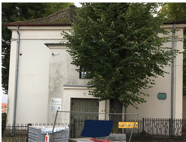
Zdjęcie 1 – Widok elewacji północnej
