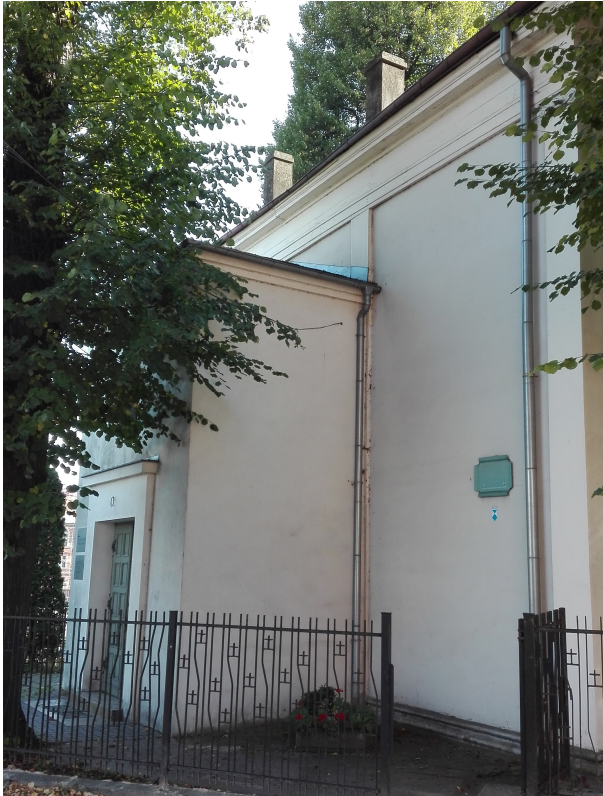
Zdjęcie 7 – Zbliżenie elewacji północnej
