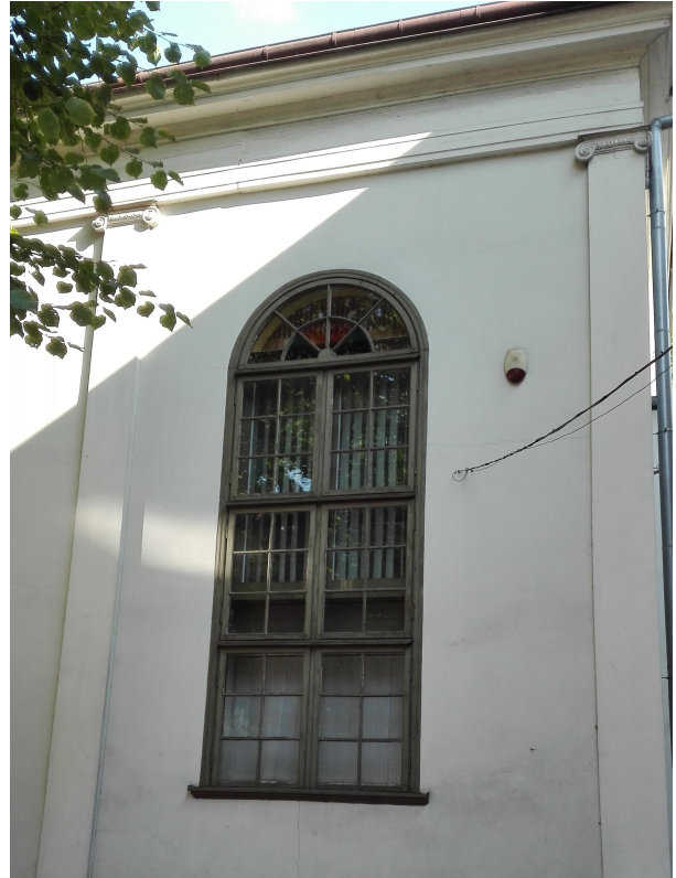
Zdjęcie 8 – Zbliżenie okna oraz detali architektonicznych elewacji zachodniej
