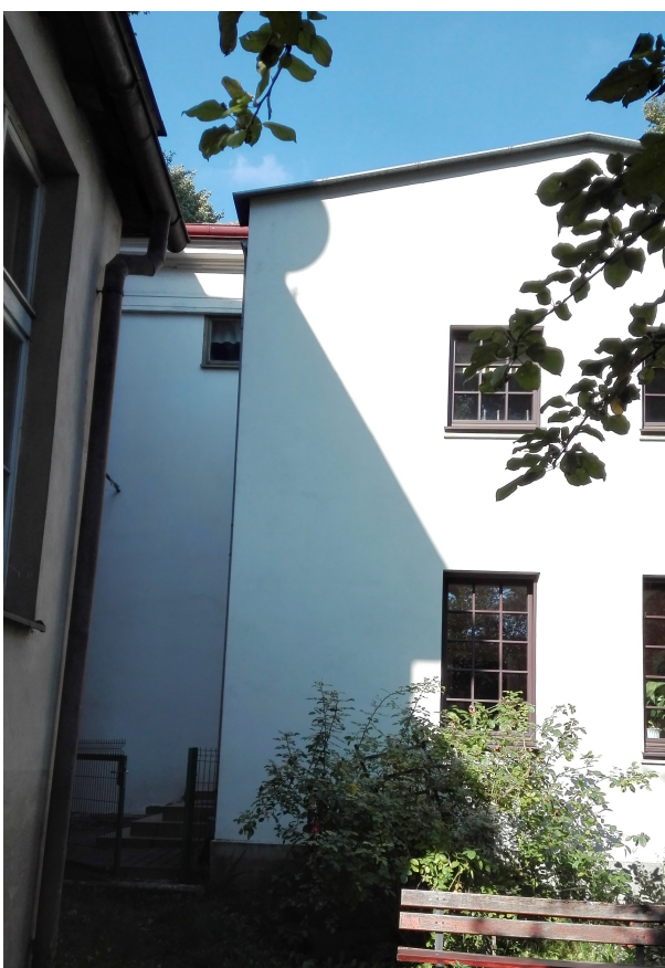
Zdjęcie 3 – Widok części elewacji południowej
