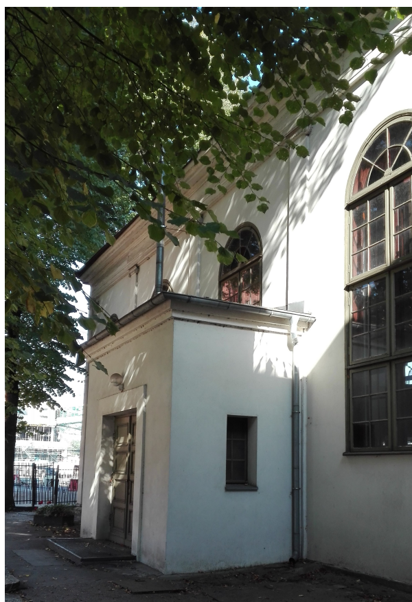
Zdjęcie 4 – Zbliżenie elewacji zachodniej
