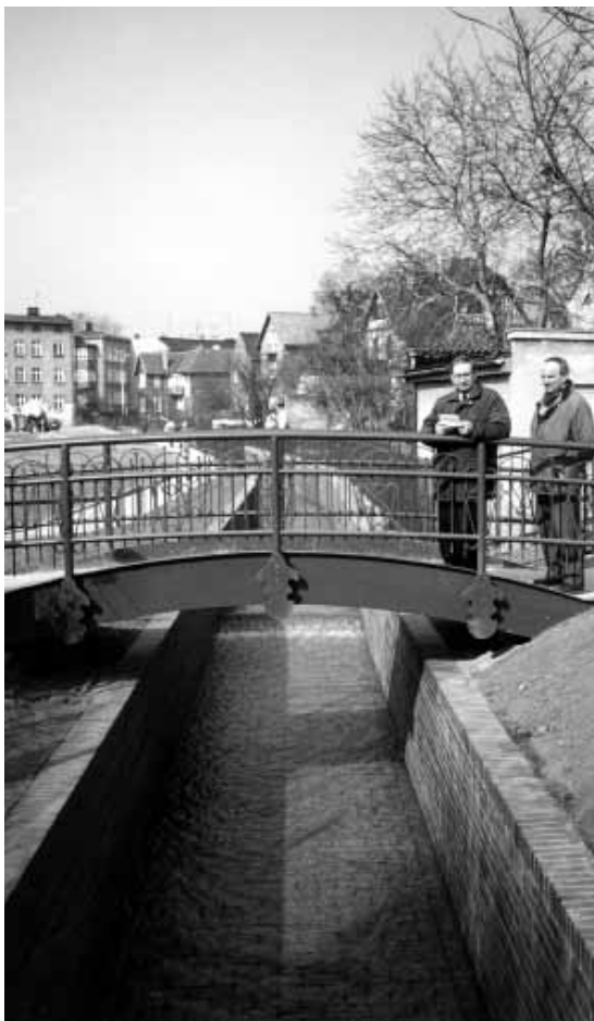
Tak wyglądało zmodernizowane koryto Strzyży i nowo zbudowana kładka tuż po zakończeniu prac, czyli wiosną 1999 r.
