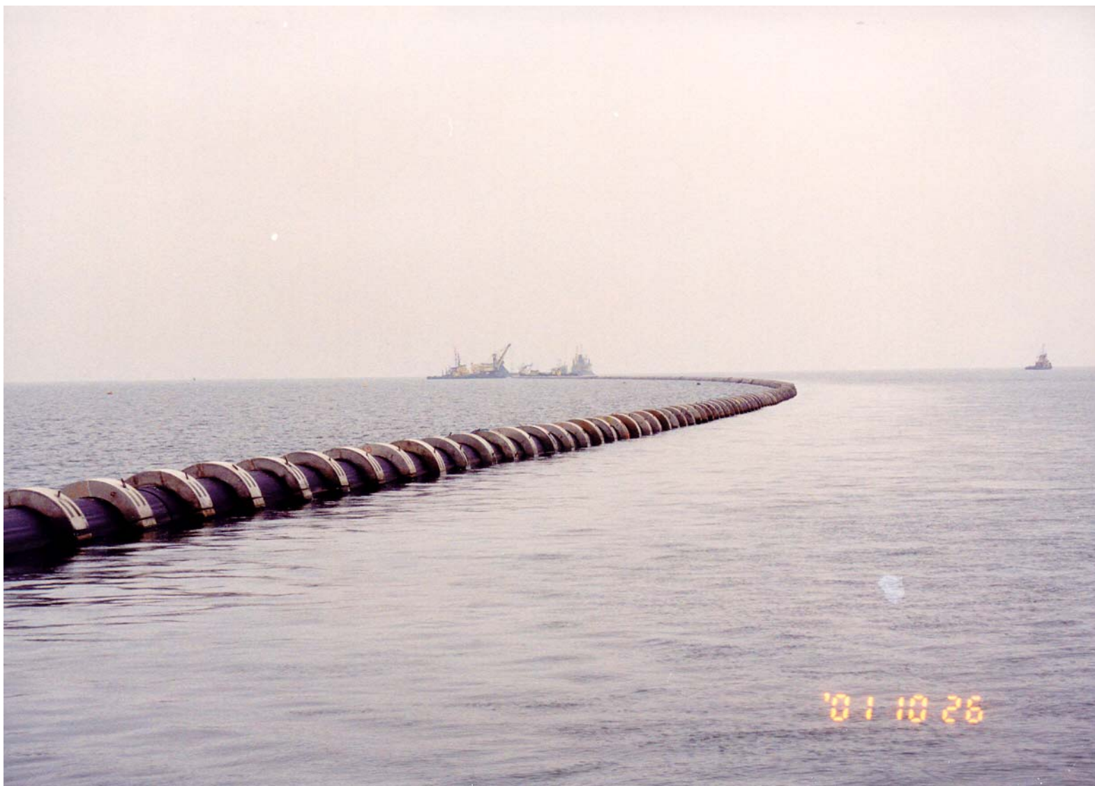
Zdjęcie przedstawiające fazę montażu kolektora wyprowadzającego oczyszczone ścieki z oczyszczalni Wschód na odległość 2,4 km w głąb Zatoki Gdańskiej. (widok od strony Wyspy Sobieszewskiej)
