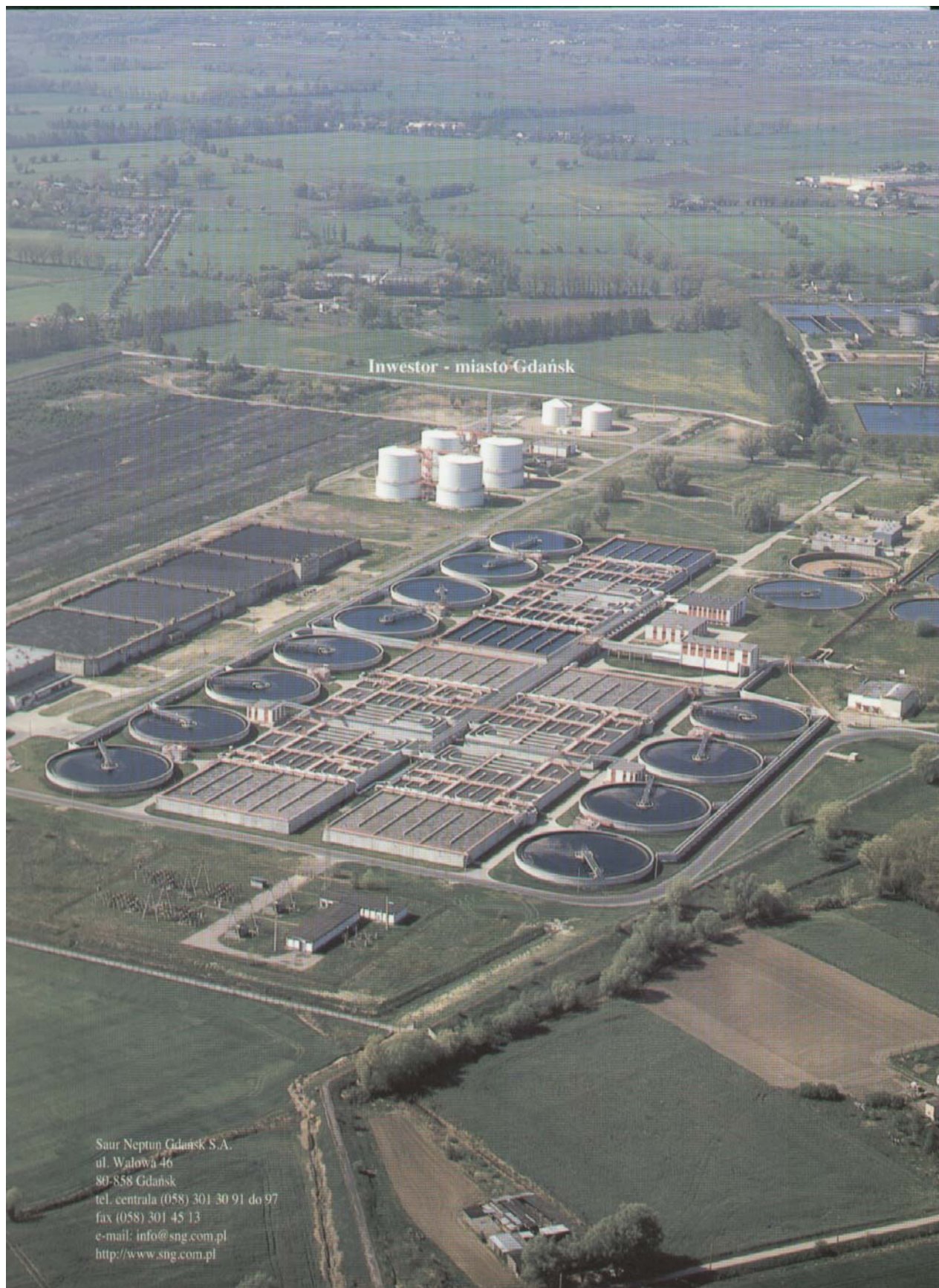
Oczyszczalnia ścieków "Gdańsi-Wschód"
