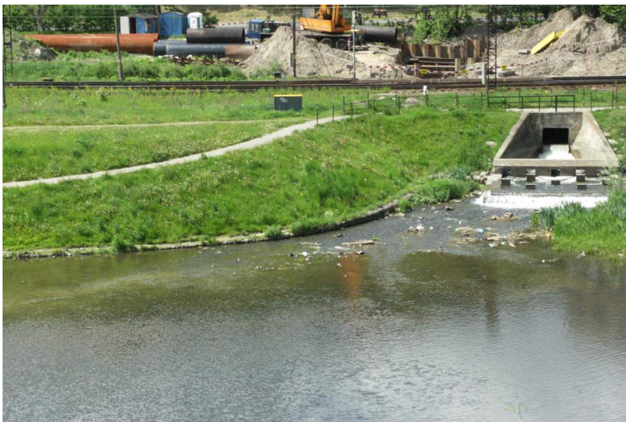
Oplyw Motławy przed wykonaniem budowli wylotowej fot. L. Makara
