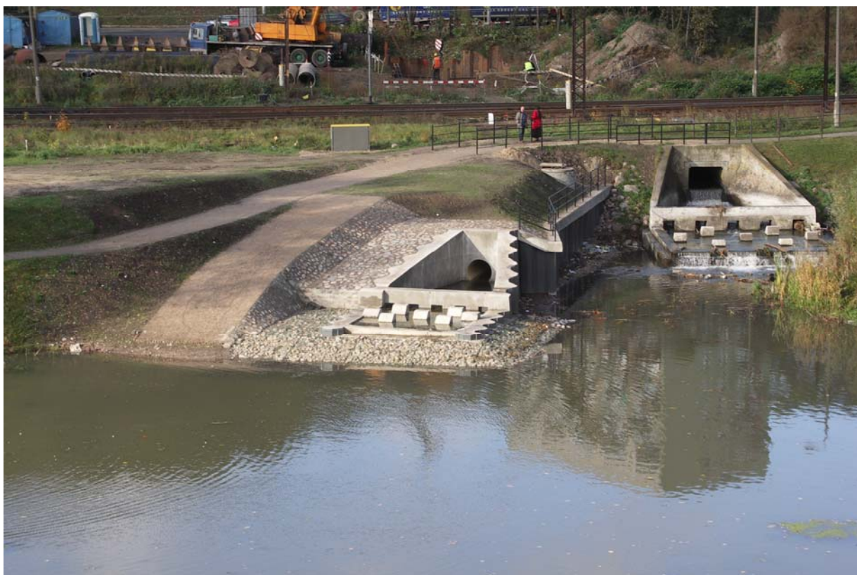
Budowla wylotowa do Oplywu Motławy fot. L. Makara
