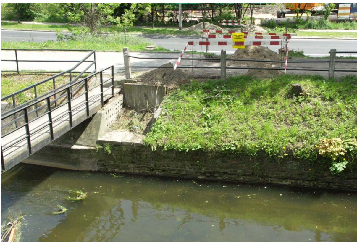
Kanal Raduni przed wykonaniem budowli wlotowej fot. L. Makara
