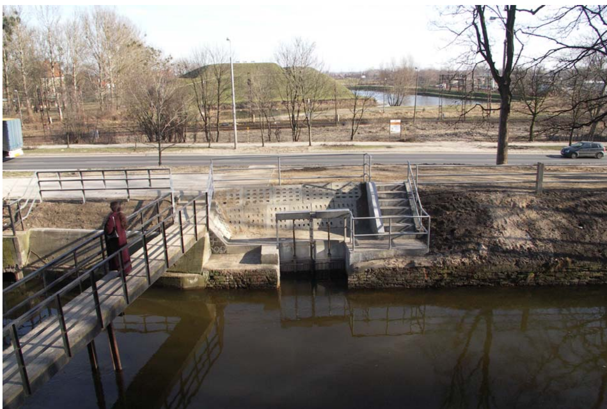
Budowla wlotowa z Kanalu Raduni fot. L. Makara
