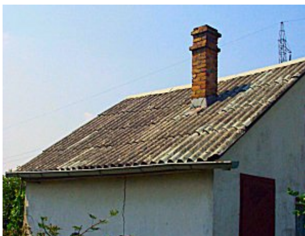
Rys.9: Pokrycie dachowe z azbestu i jego wymiana
