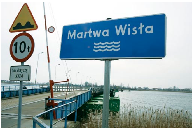
Most pontonowy na Martwej Wiśle.
