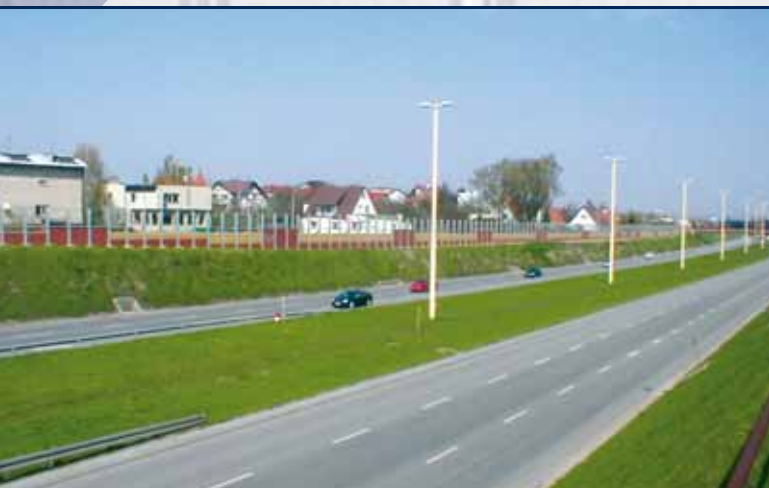
Widok ekranu akustycznego przy ul. Armii Krajowej w rejonie Osiedla Wzgórze Mickiewicza.
