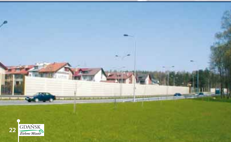
Widok ekranu akustycznego przy ulicy Słowackiego w rejonie Osiedla Muzycznego.
