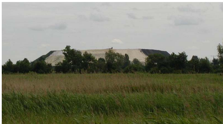
Rys. 14 Rekultywacja składowiska fosfogipsów z wykorzystaniem osadów ściekowych.
