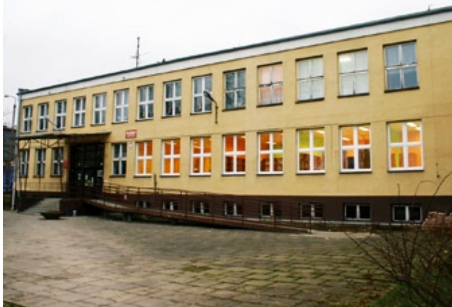
Wyremontowano pomieszczenia biblioteki i czytelni w SP 22 oraz pomieszczenie, w którym rozpocznie działalność Dom Otwarty. Wszystkie pomieszczenia będą udostępnione mieszkańcom również po zaprzestaniu działalności edukacyjnej szkoły podstawowej.
