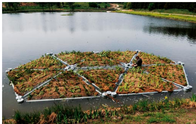
Montaż wysp pływających.
