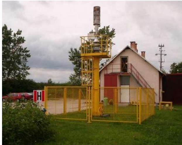
Rys.2: Instalacja odzysku biogazu (po lewej – studnia gazowa; po prawej – elektrownia biogazowa).
