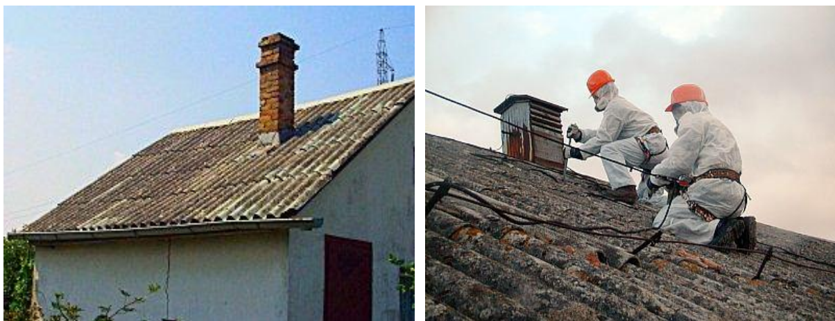
Rys.16: Pokrycie dachowe z azbestu i jego wymiana (po prawej).
