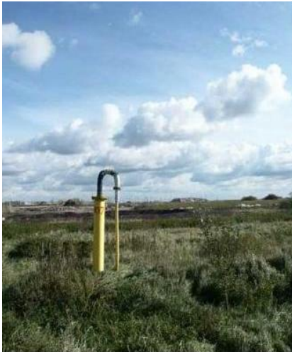
Rys.2: Instalacja odzysku biogazu (po lewej – studnia gazowa; po prawej – elektrownia biogazowa).
