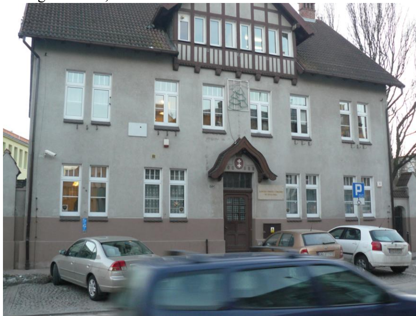
Gdańsk ul. Partyzantów 36 – zainstalowana stacja monitoringu hałasu
