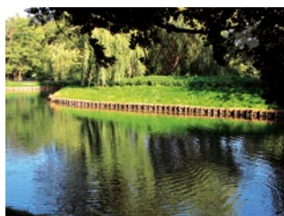
Nowe umocnienia brzegowe zbiornika Jelitkowskiego.
