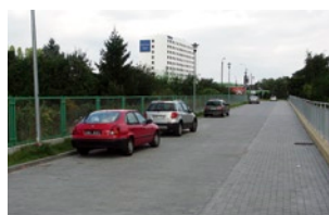
Droga wykonana wraz z budową kanalizacji na odcinku od ul. Jelitkowskiej do zbiornika Orłowska II.
