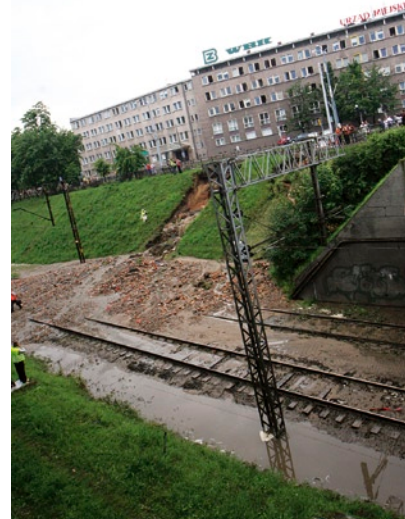
Budowa „syfonu” zakończyłaby się szybciej, gdyby nie uległ zniszczeniu 1 lipca br. podczas ulewy, która przeszła nad Gdańskiem.
