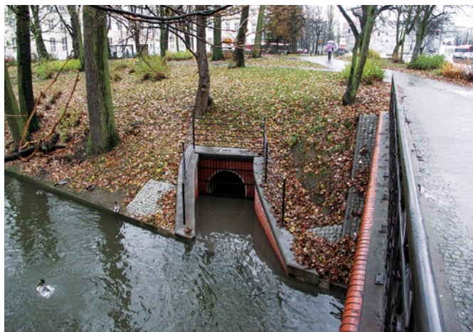
Wylot kanalizacji deszczowej do Kanału Raduni.
