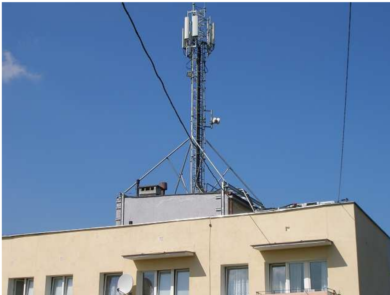
Zdjęcie 1. Stacja przekaźnikowa telefonii komórkowej
