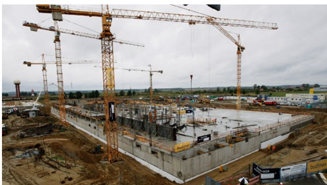
Fundamenty nowego terminala już są.
