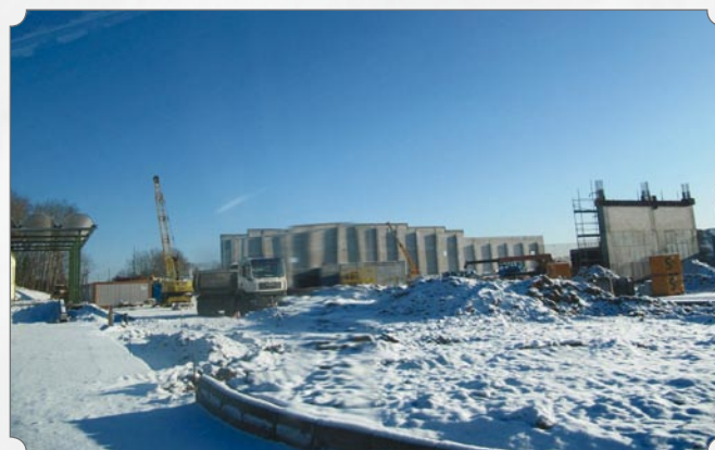
Budowa zakładu zagospodarowania odpadów.
