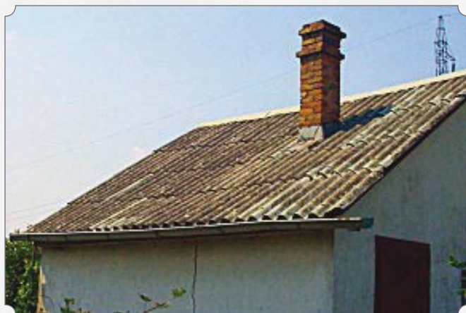
Pokrycie dachowe z azbestu...
