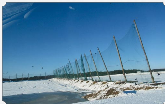
Nowa kwatery składowania odpadów – oddana do użytku 02.01.2010r.
