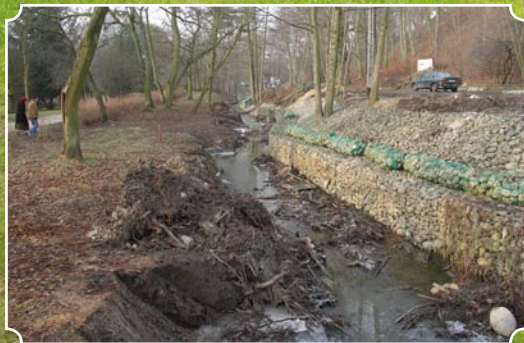
Odcinek ujściowy potoku przed i po regulacji
