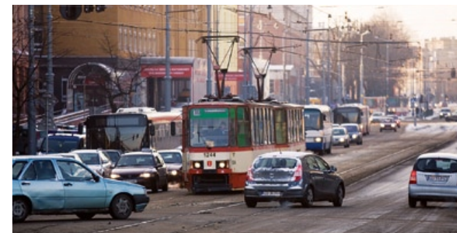
Po wymianie torów i nawierzchni ulicy na Nowych Ogrodach i Kartuskiej przywrócono zarówno ruch kołowy, jak i tramwajowy.
