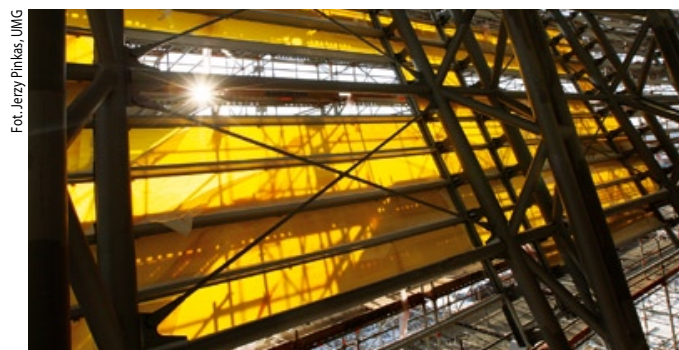
Pierwsze poliwęglane imitujące bursztyn montowane są na poszyciu stadionu.
