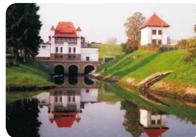
Budynek elektrowni w Straszynie, fot. Katarzyna Trojanowska
