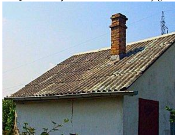
Rys.19: Pokrycie dachowe z azbestu i jego wymiana (po prawej)
