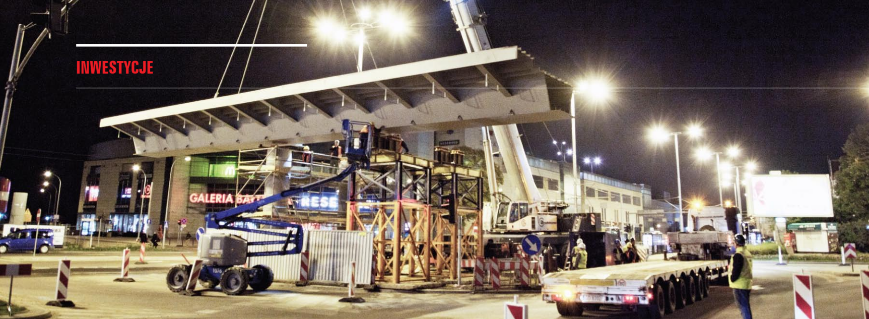
Budowa Trasy Słowackiego
