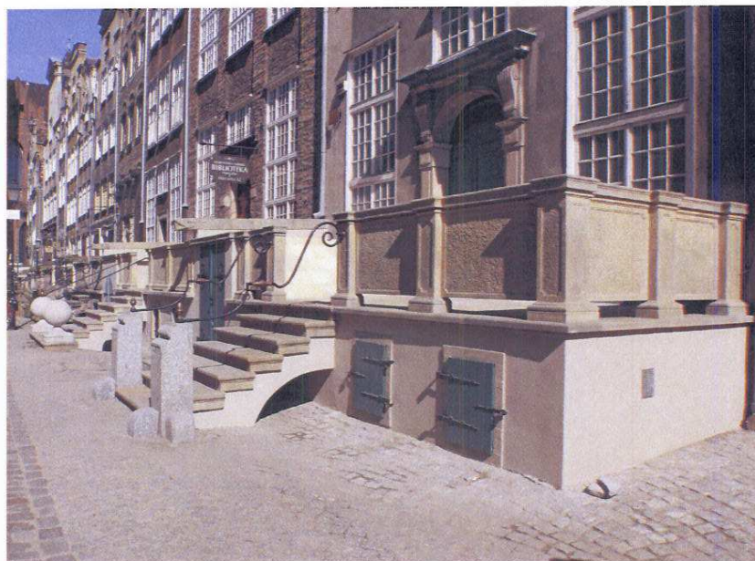
Przedproża po remoncie
