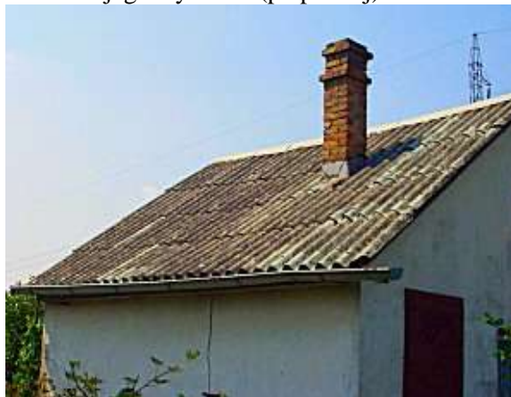
Rys.13: Pokrycie dachowe z azbestu i jego wymiana (po prawej)
