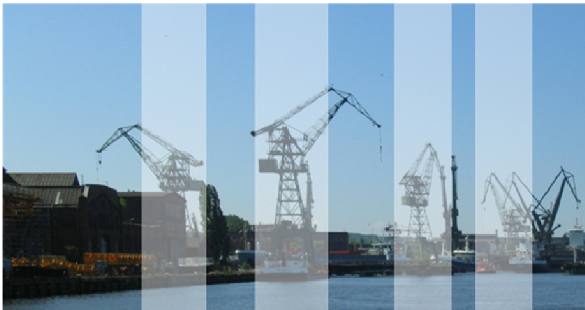
il.19. Grupa 4 podobnych dźwigów Nabrzeża Remontowego M3-M6
