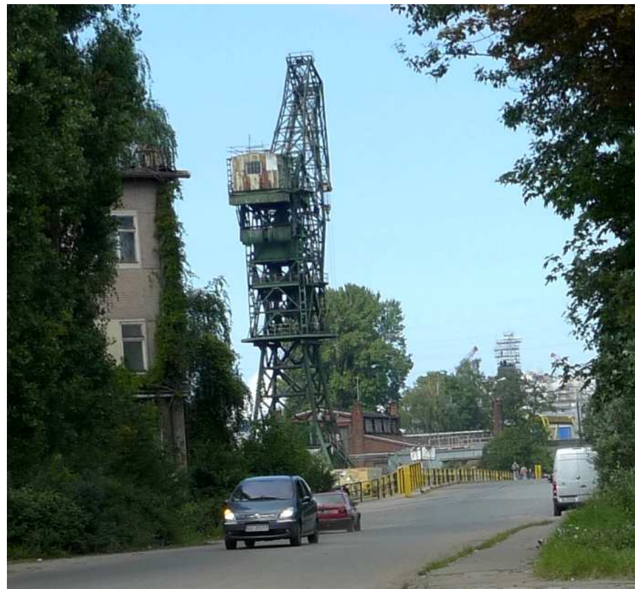
il.24. Dźwig W29 na osi projektowanego bulwaru Drogi do Wolności
