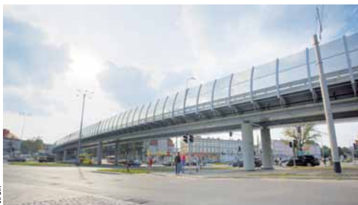
Wiadukt nad al. Grunwaldzką daje możliwość bezkolizyjnego przejazdu nad tą ruchliwą ulicą
