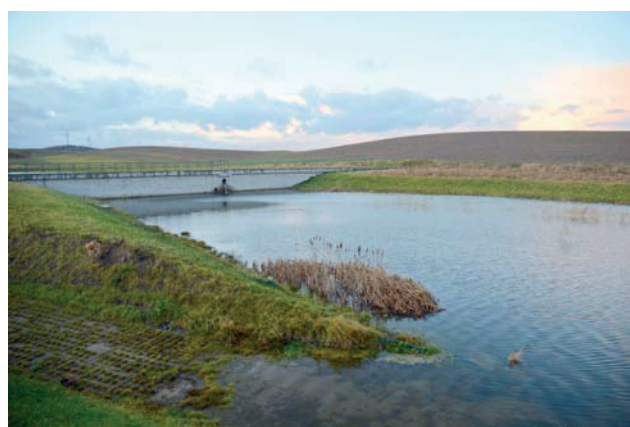
Zbiornik Zr – 2b i zapora na zbiorniku Zr – 2a
