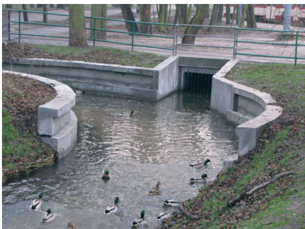
Wylot Kanału Ulgi do Potoku Jelitkowskiego
