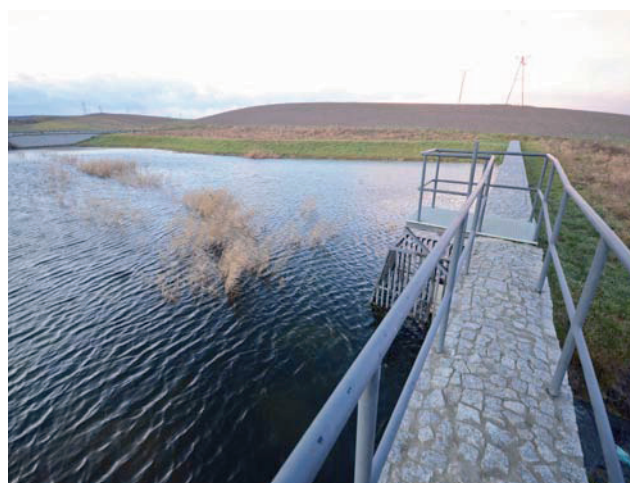
Zapora na zbiorniku Zr – 2b
