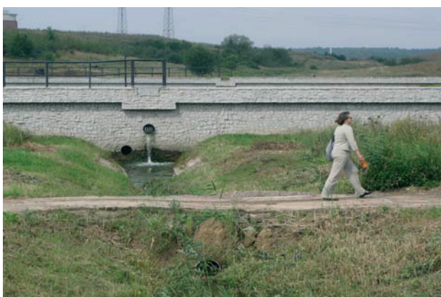
Zapora na zbiorniku Zr – 2b
