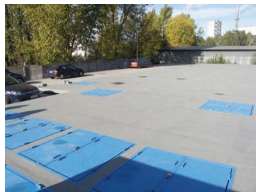
Widok zakrytego zbiornika po ukończeniu robót
