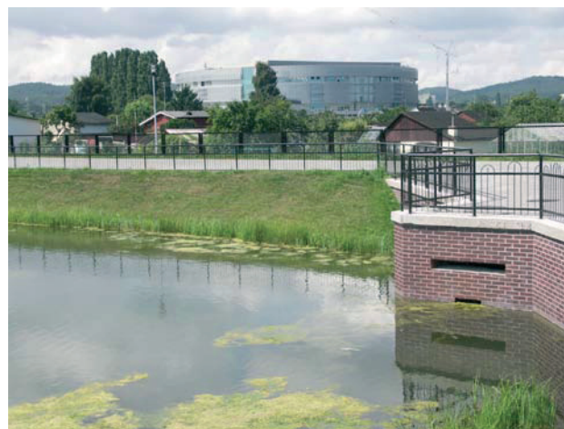
Budowla upustowa na zbiorniku
