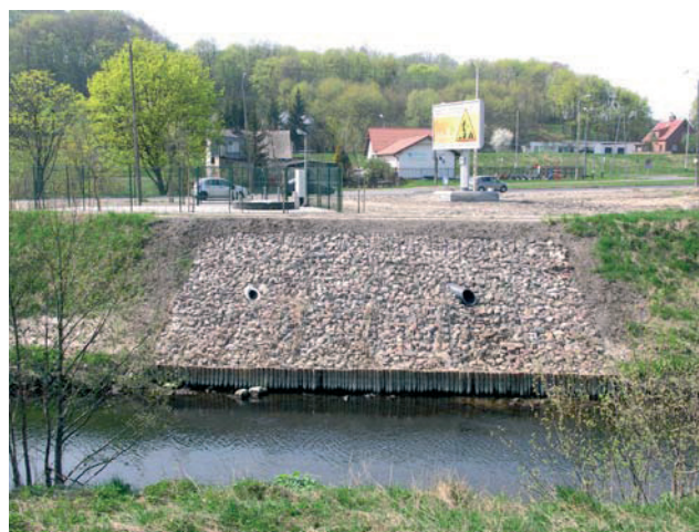
Nowe wyloty kanalizacji deszczowej do rzeki Raduni
