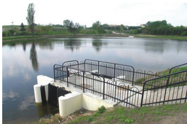
Budowla wylotowa ze zbiornika
