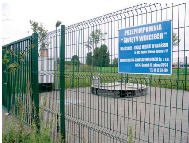
Przepompownia Święty Wojciech
