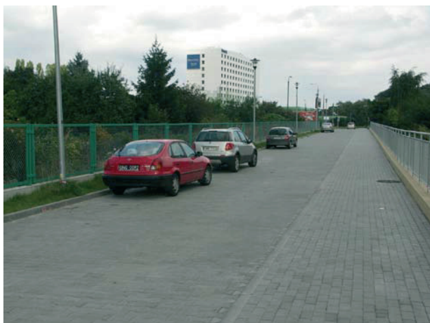
Nowa droga wraz z kanalizacją deszczową na odcinku od ul. Jelitkowskiej do zbiornika Orłowska II
