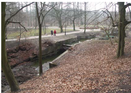
Jaz przed remontem...
