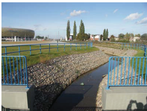
Kanał Warzywód III po przebudowie
