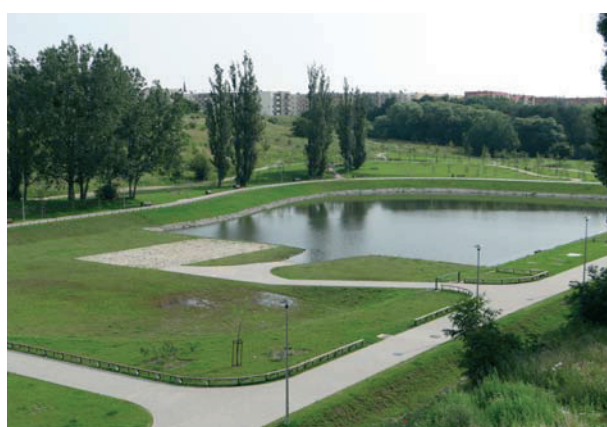
...i po zrealizowaniu inwestycji
