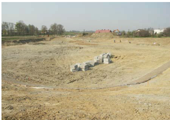
Zbiornik w trakcie ...
