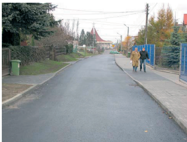
Ulica po przebudowie
