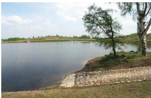
Droga techniczna przy zbiorniku
