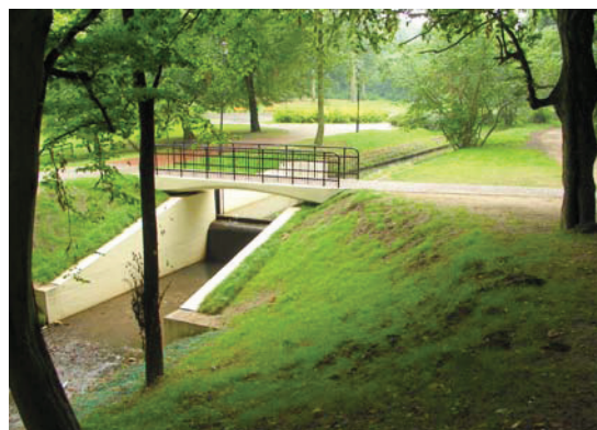
...i po remoncie
