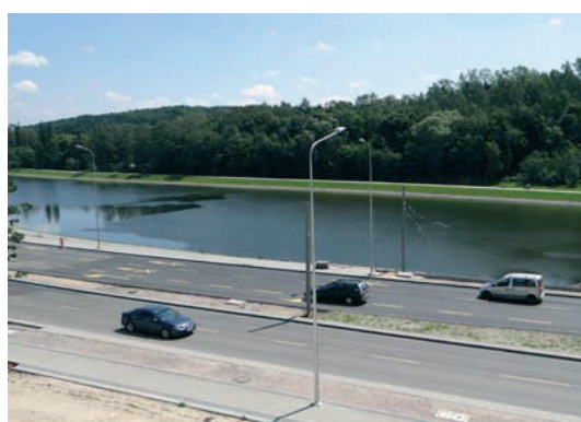
... i po zrealizowaniu inwestycji
