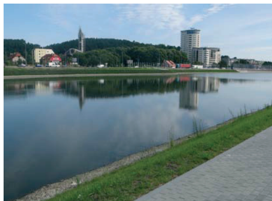
... i po zrealizowaniu inwestycji
