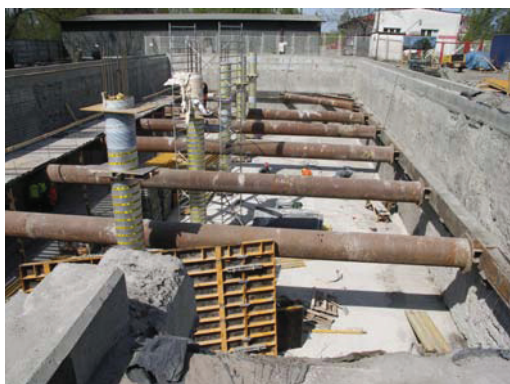
Zbiornik przepompowni Wielopole w trakcie robót
