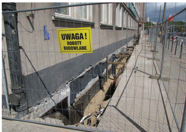
Prace przy izolacji ścian budynku Urzędu Miejskiego
