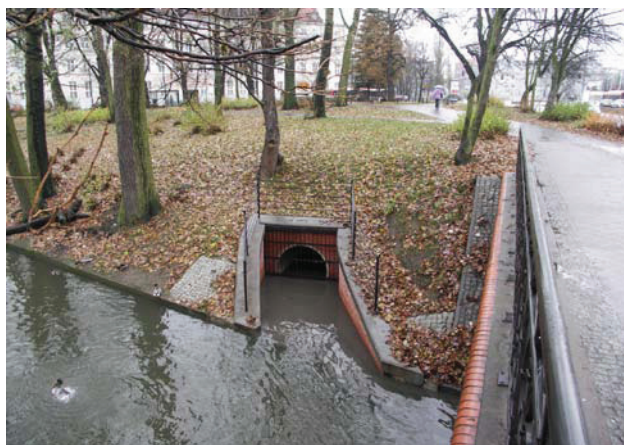
Wylot kanalizacji deszczowej do Kanału Raduni
