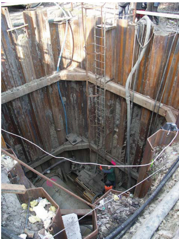
Komora przeciskowa w trakcie wykonywania syfonu
