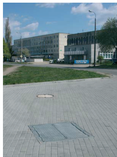
Plac manewrowy w rejonie separatora
