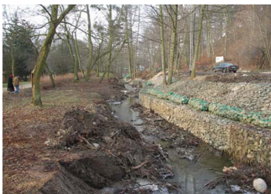
Odcinek ujściowy potoku przed...
