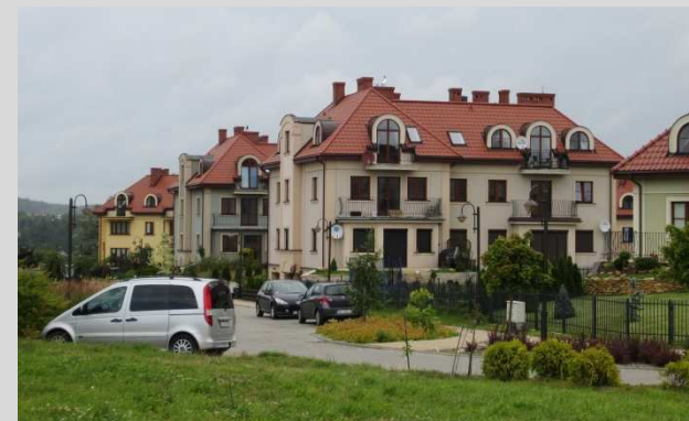
Zabudowa wielorodzinna – Straszyn. fot. M. Turzyński
