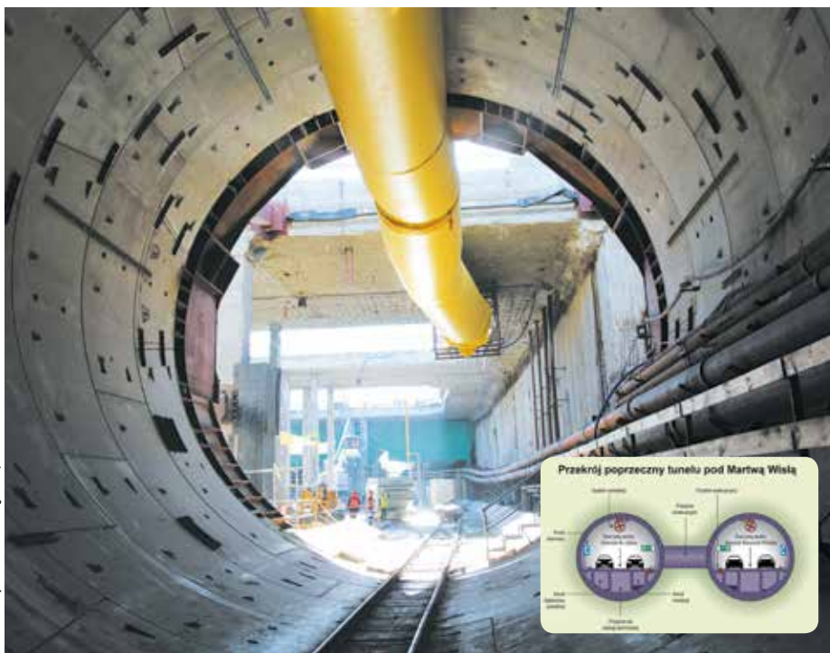
Tak wygląda wydrążona część tunelu. Postój serwisowy maszyny odbył się po przebyciu 1/3 drogi
