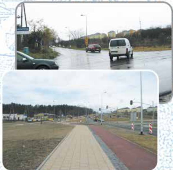
Budowa ulicy Nowej Łódzkiej
