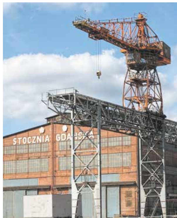
Wysokość całej konstrukcji wynosi 41,2 m, w tym wysokość żurawia wieżowego to 19,6 m,
