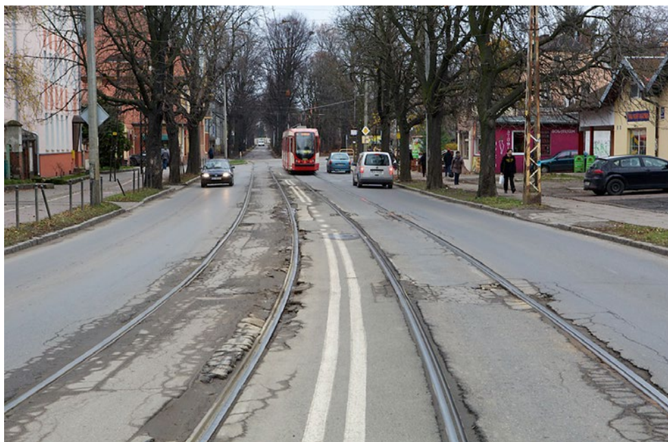
Gdański Projekt Komunikacji Miejskiej etap III C obejmuje modernizację 4,4 km wysłużonego torowiska.
