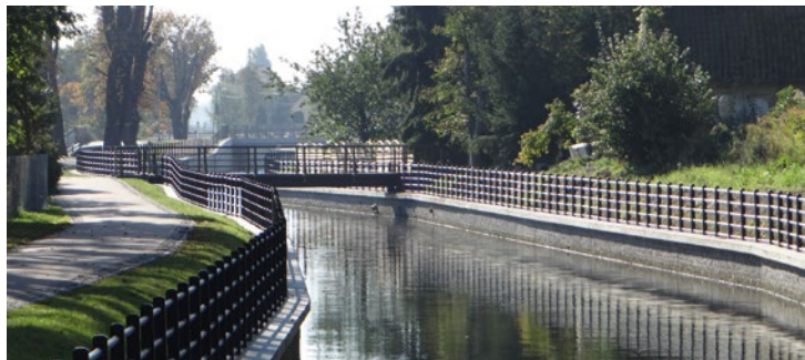
Przebudowanym wałem kanału biegnie wygodna ścieżka dla pieszych i rowerzystów.
