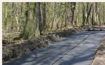
Budowa nowej drogi w obszarze Natura 2000 w okolicach Berlina.
