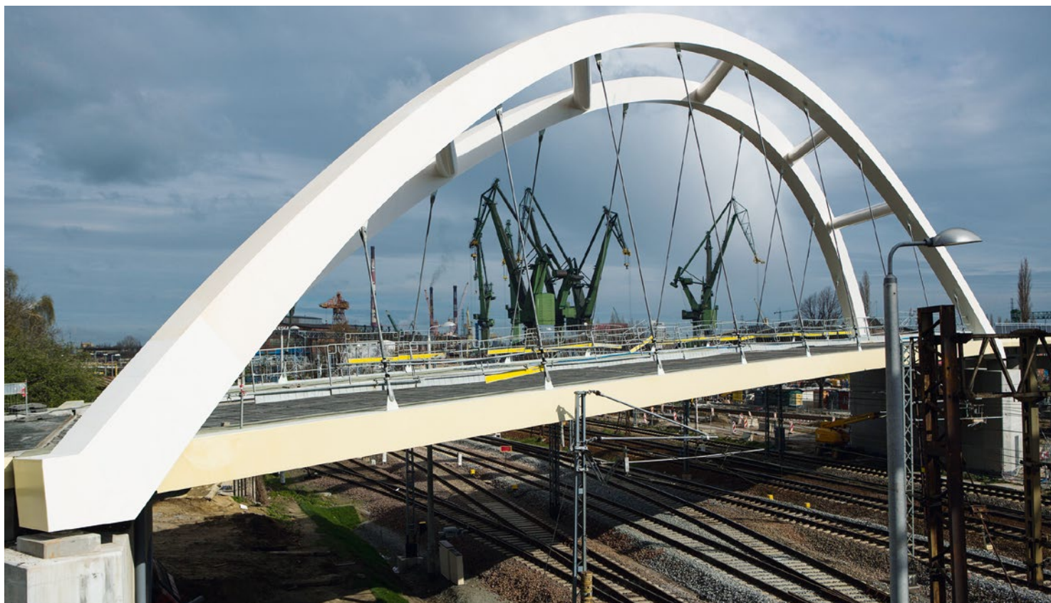
Nowa Wałowa – zupełnie nowa droga i estakada nad torami kolejowymi.
