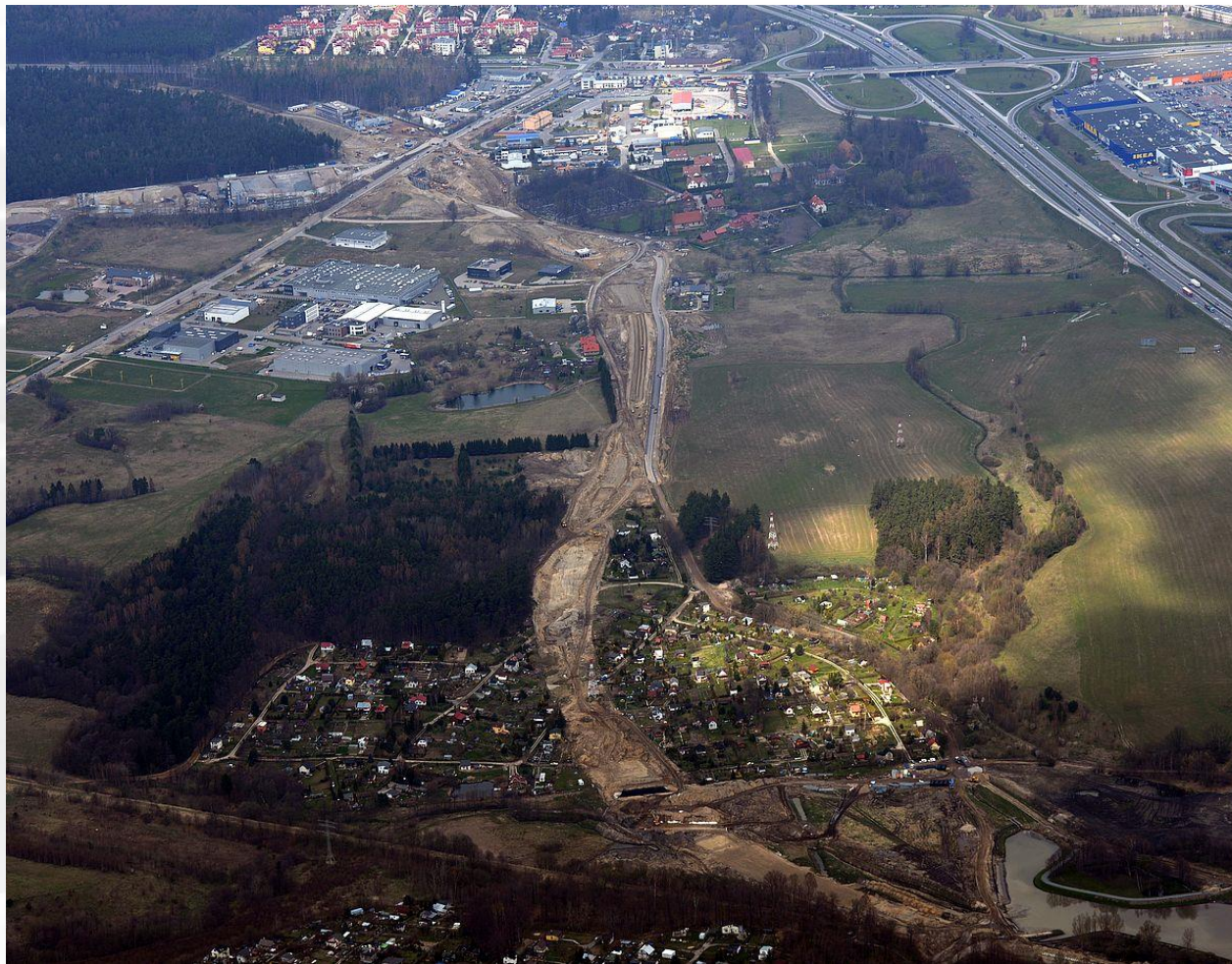
Odcinek: Karczemki - Matarnia
