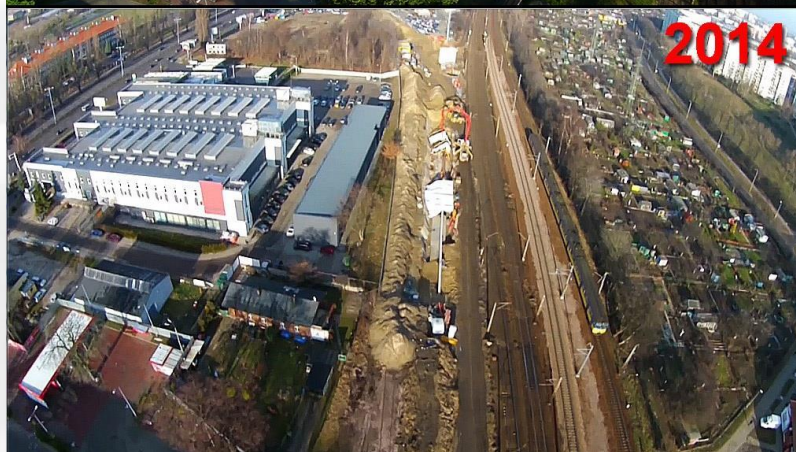
Mur oporowy M 2 na wysokości SKM Zaspaska
