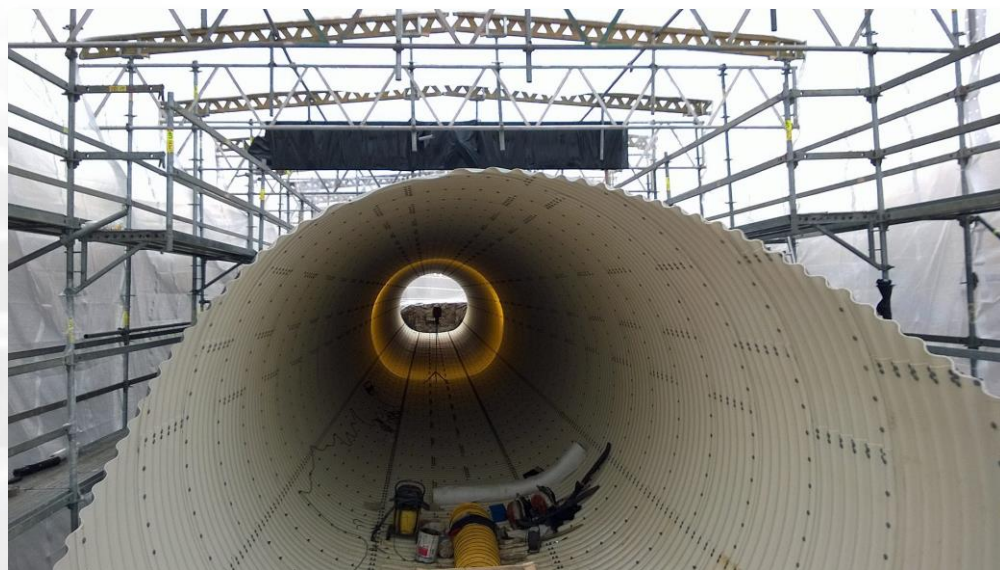
Przepust PZ 12 (strumień Strzyża)
