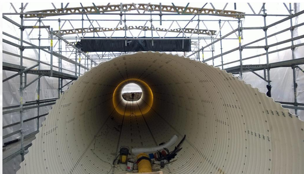
Przepust PZ 12 (strumień Strzyża)
