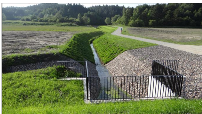
Uregulowany potok poniżej budowli piętrząco-upustowej
