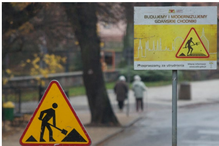
Do końca tego roku w ramach Programu wyremontowanych zostanie ponad 21 km chodników na terenie Gdańska. Łączny koszt wszystkich prac przeprowadzonych w 2014 roku to ponad 16 mln zł.
