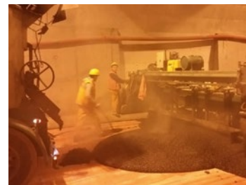
Budowa tunelu pod Martwą Wisłą toczy się pełną parą, a pierwsza z podziemnych nitek, czyli T1, jest coraz bliższa swojego docelowego wyglądu.
