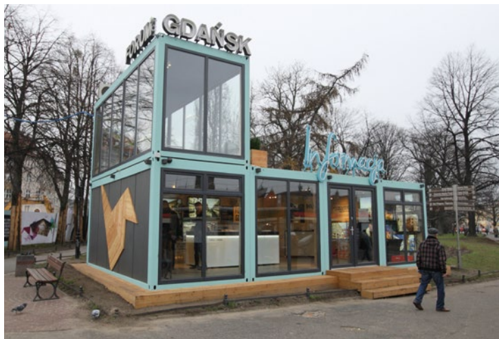
Z górnego poziomu punktu info rozpościera się widok na całą budowę.
