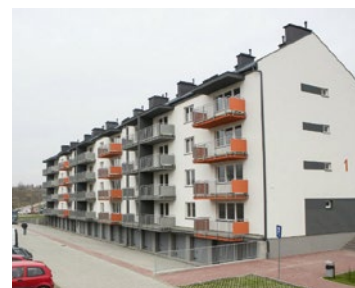
Wiele nowych osiedli powstaje na południu Gdańska.
