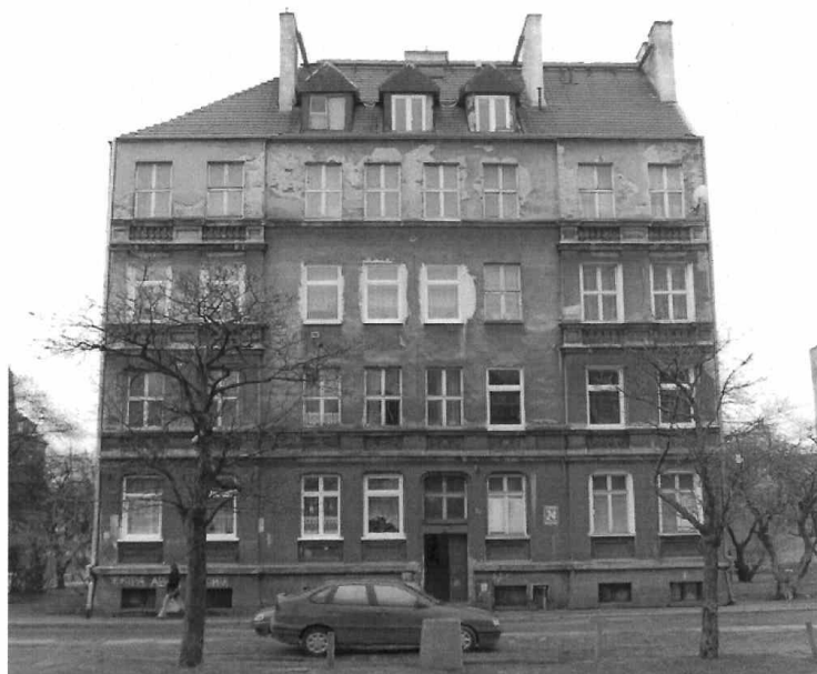
Budynek przy ul. Wróbla 24 przed termomodernizacją
