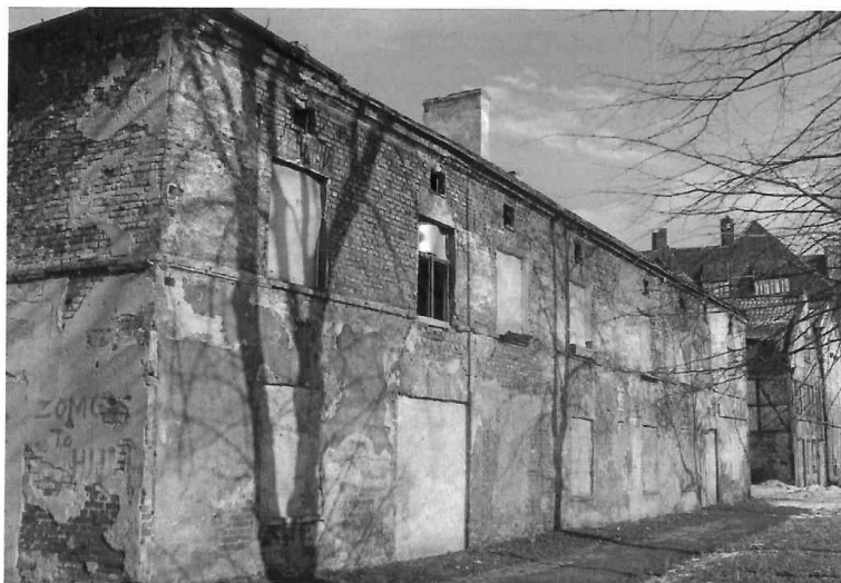
Budynek przy ul. Reduta Wyskok 4/5 przed rozbiórką
