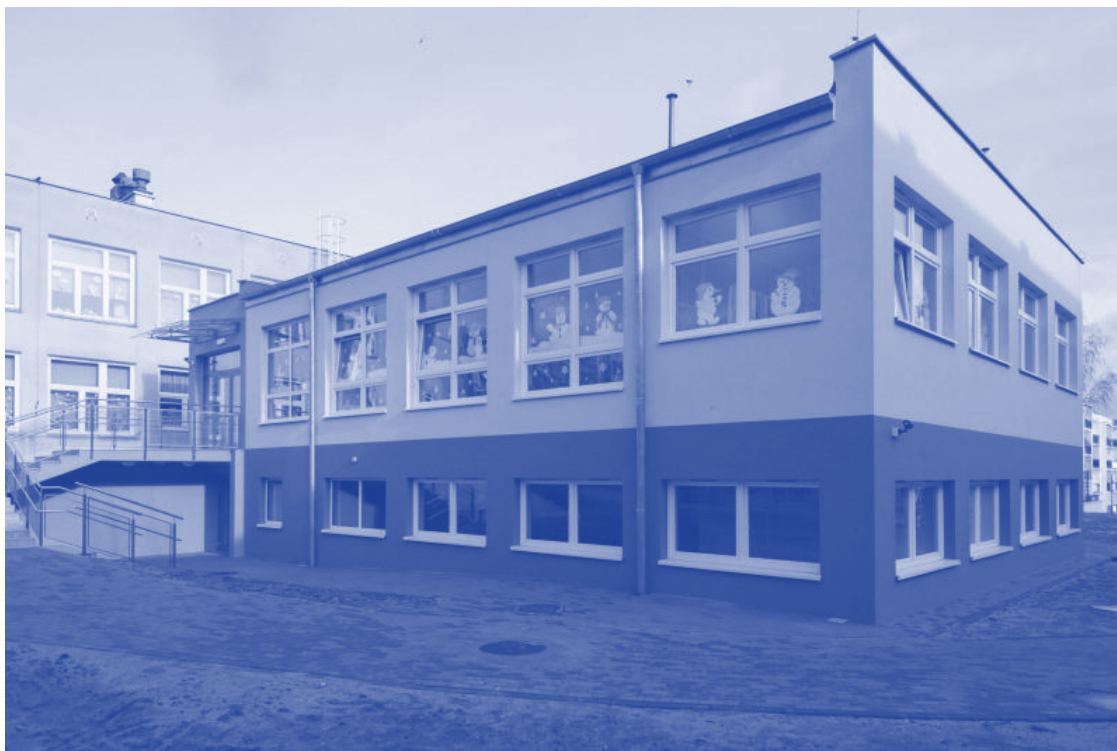
ryc. 11. Wyremontowana i przebudowana część przedszkola nr 85, fot. Wojtek Jakubowski
