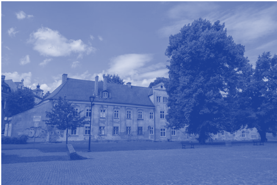
ryc. 12. Nowa instytucja kulturalna w Gdańsku - Dom Chodowieckiego i Grassa - powstanie w zabytkowych budynkach dawnego sierocińca. Będzie pełnić rolę centrum rezydencyjnego, przestrzeni na wystawy i centrum konferencyjno-warsztatowego; fot. Dominik Paszliński
