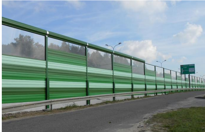
Rysunek 13: Ekran akustyczny wraz z dyfraktorem oktagonalnym wzdłuż obwodnicy S6 w dzielnicy Osowa (źródło: www.osowa24.pl )
