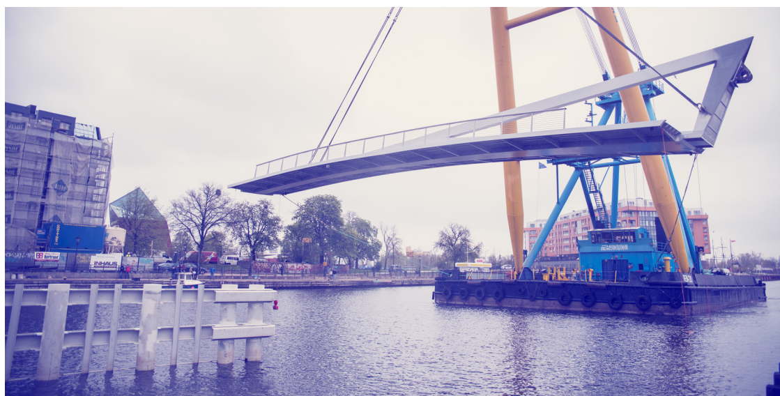
ryc. 8. Montaż zwodzonego przęsła kładki pieszej na Ołowiankę; fot. Dominik Paszliński / gdansk.pl
