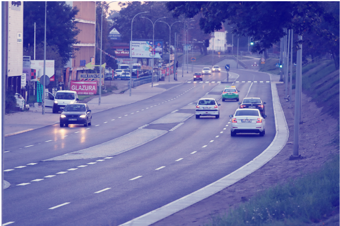
ryc. 14. Wyremontowany odcinek Traktu Św. Wojciecha; fot. Grzegorz Mehring, / gdansk.pl
