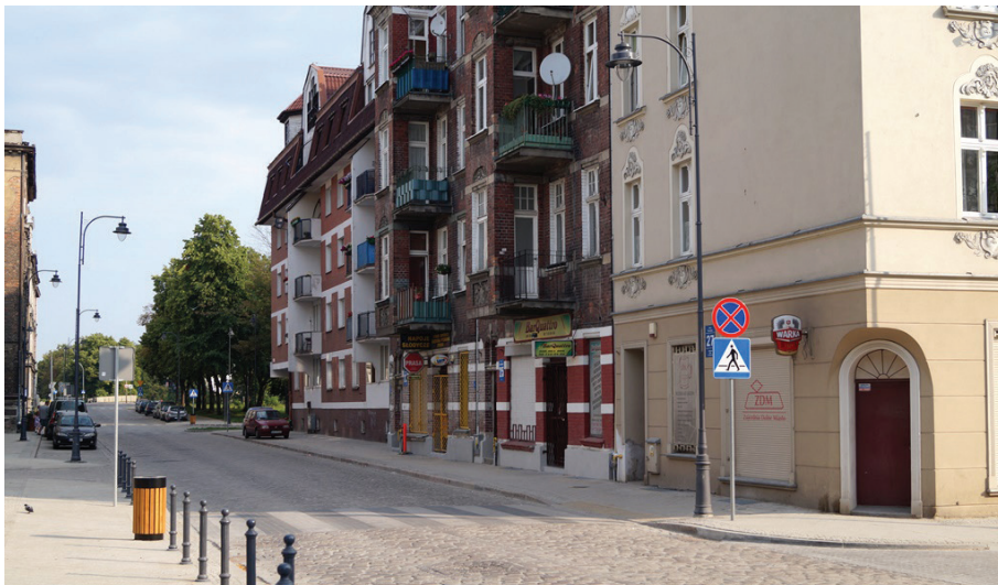
Budynek dawnej łaźni na Dolnym Mieście
