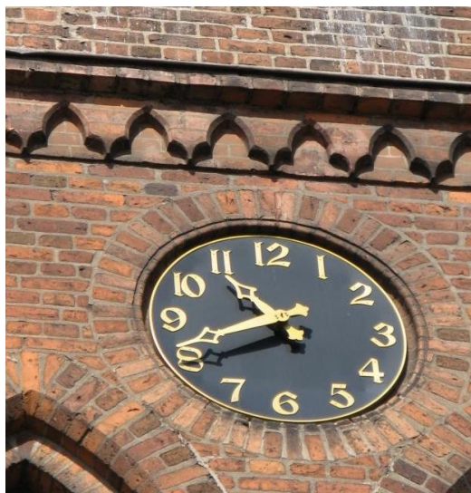
4. Zegar na fasadzie wraz z detalem murarskim
