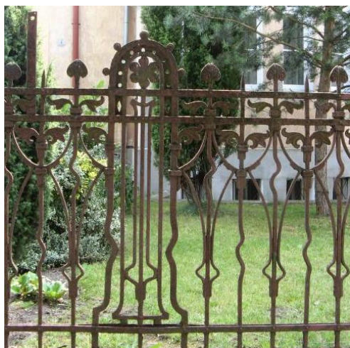
12. Detal ogrodzenia szkoły - płot
