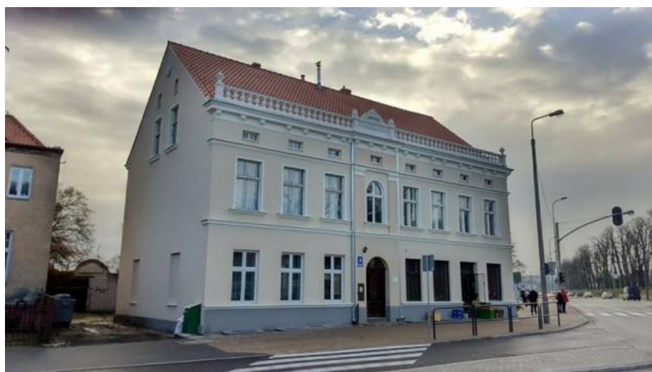
15. Fasada kamienicy przy ul. Gościnniej 2
