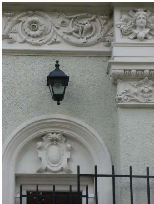
18. Dekoracyjne belkowanie, pilaster i okno
