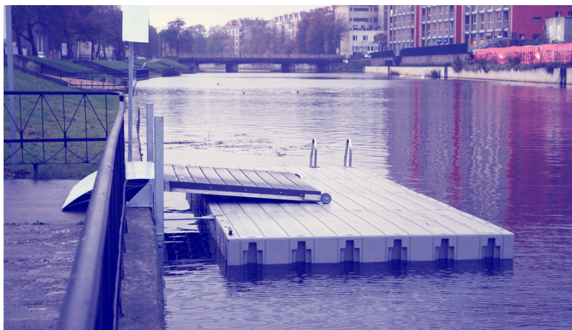
ryc.10. Nowy pomost zbudowany na potrzeby sportu i turystyki kajakowej na Motławie wzdłuż ul. Kamienna Grobla; fot. DRMG
