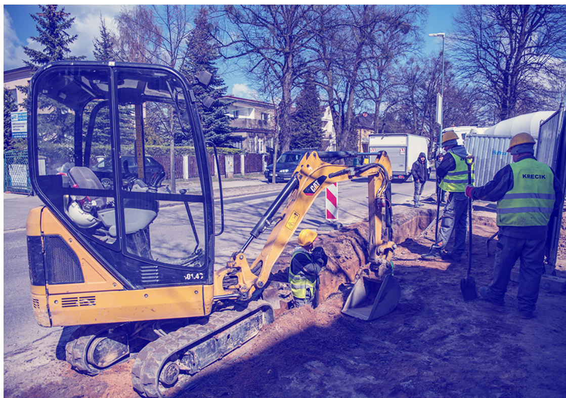
ryc. 3 Przebudowa sieci wodociągowej w ul. Piastowskiej; fot. Dominik Paszliński / gdansk.pl
