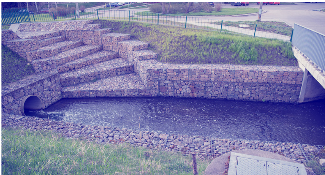
ryc. 12. Umocnienia zbiornika retencyjnego Nowiec II zlokalizowanego przy ul. Potokowej w Matemblewie; fot. Dominik Paszliński / gdansk.pl
