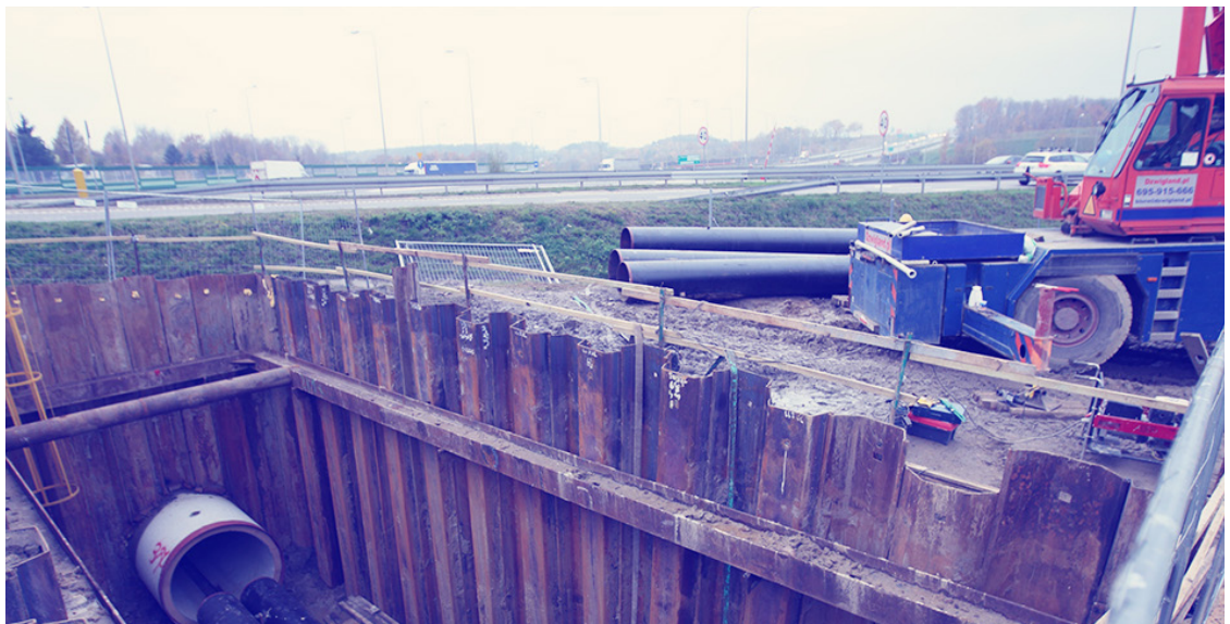
ryc. 4 Przekop pod obwodnicą w stronę Matarni, realizowany w ramach rozbudowy sieci ciepłowniczej Gdańska; fot. Grzegorz Mehring / gdansk.pl
