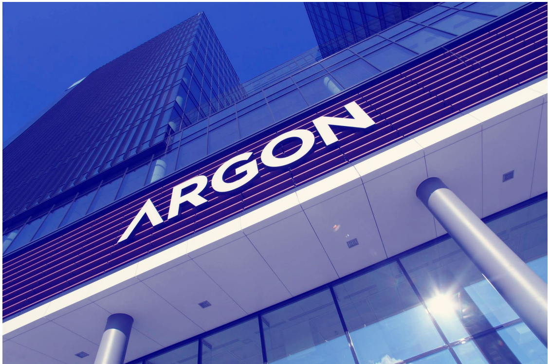
ryc. 13. W 2017 r. oddano do użytku m.in. biurowiec Argon, który jest efektem trzeciego etapu rozbudowy kompleksu biurowego Alchemia. Stanowi on jednocześnie część biegnącego wzdłuż al. Grunwaldzkiej pasma usługowego, w którym zlokalizowany jest również kompleks Olivia Business Centre; fot. www.facebook.com/AlchemiaGdansk
