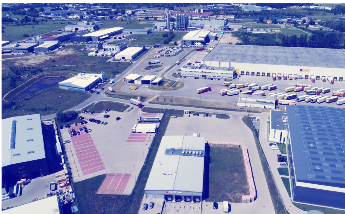
ryc. 9. Park Przemysłowo-Technologiczny „Maszynowa” zlokalizowany w dzielnicy Kokoszkki zapewnia dogodny dostęp do Obwodnicy Trójmiasta i Portu Lotniczego Gdańsk; fot. archiwum GARG
