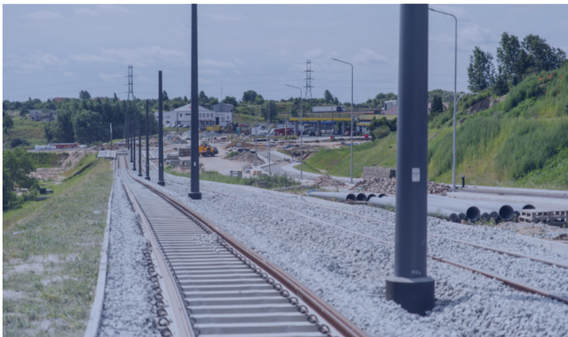
ryc. 11. Budowa torowiska wzdłuż powstającej ul. Nowej Bulońskiej; fot. Dominik Paszliński/gdansk.pl
