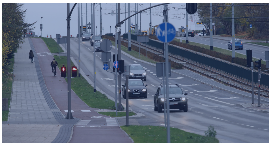
ryc. 7. Nowopowstała ścieżka rowerowa przy ul. Bulońskiej; fot. Grzegorz Mehring/ gdansk.pl
