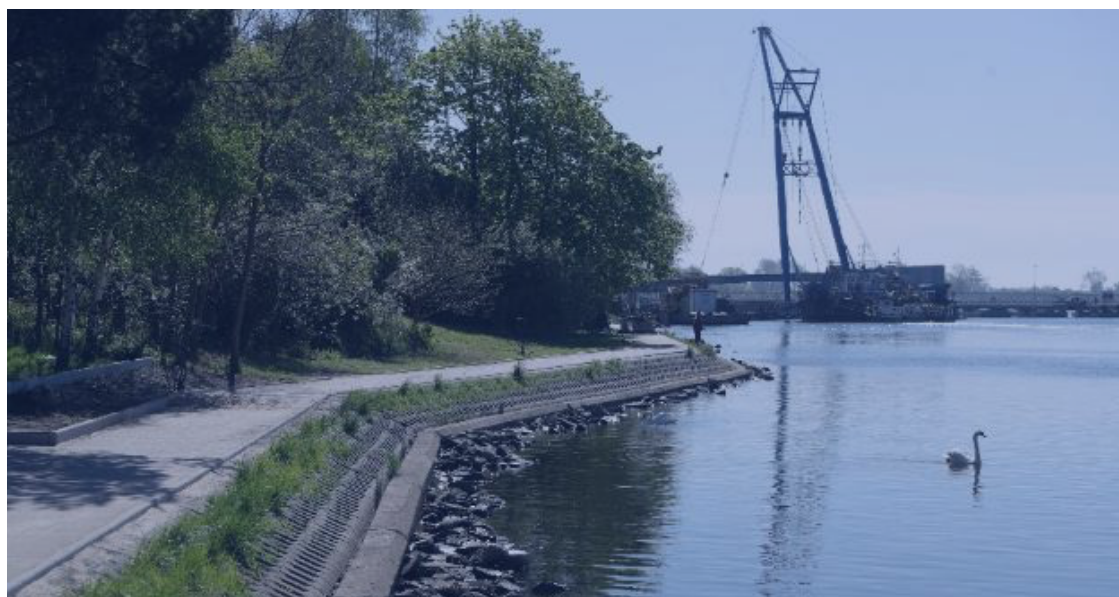
ryc. 5. Budowa chodnika wraz z oświetleniem wzdłuż Martwej Wisły na Wyspie Sobieszewskiej; fot. Grzegorz Mehring/gdansk.pl
