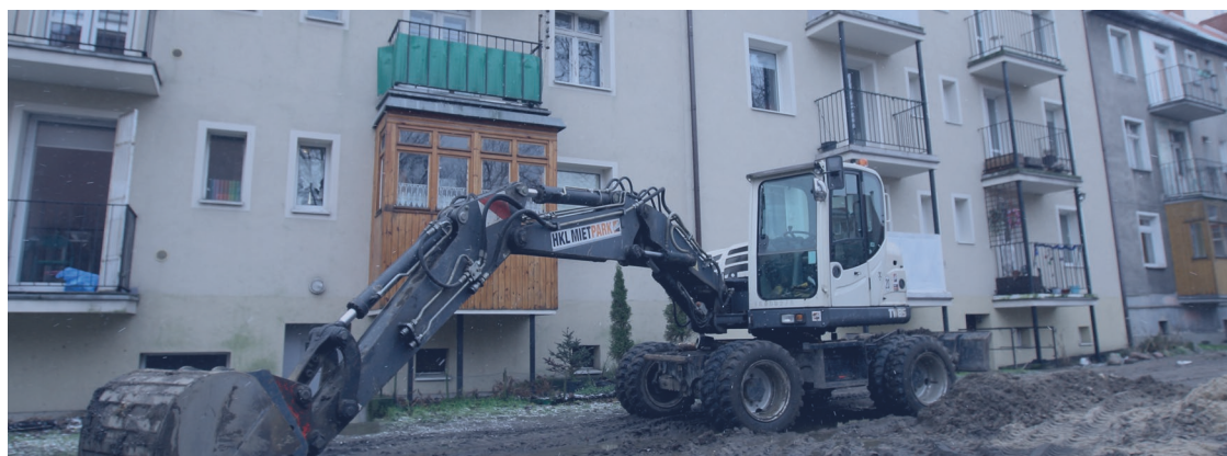
ryc. 4. Prace przy ul. Lelewela prowadzące do wymiany ogrzewania węglowego na miejską sieć ciepłowniczą w Gdańsku; fot. Grzegorz Mehring / gdansk.pl
