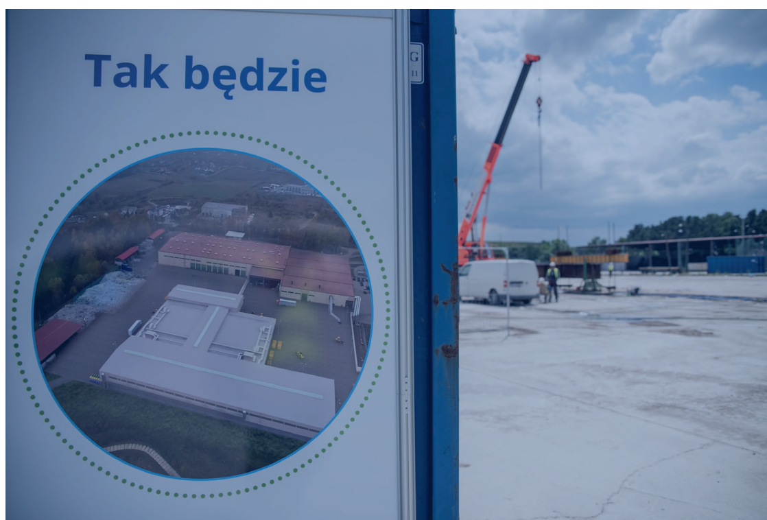
ryc. 9. Prezentacja hermetycznej kompostowni - tablica informacyjna oraz miejsce prac ziemnych; fot. Dominik Paszliński / gdansk.pl
