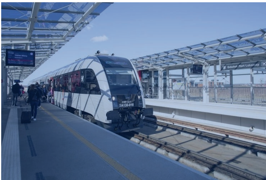
ryc. 10. Pociąg PKM na stacji Gdańsk Port Lotniczy. W ostatnich latach dynamicznie rośnie liczba zarówno podróżujących liniami Pomorskiej Kolei Metropolitalnej, jak i liczba pasażerów odprawianych na gdańskim lotnisku; fot. Jerzy Pinkas/gdansk.pl
